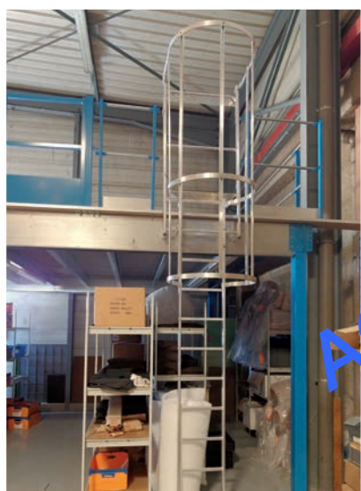
Accès occasionnel à l'étage par échelle crinoline.
