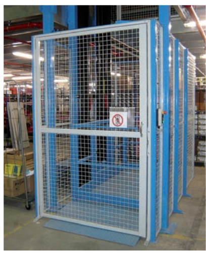
Monte-charges et porte automatique intégrés dans la structure.
